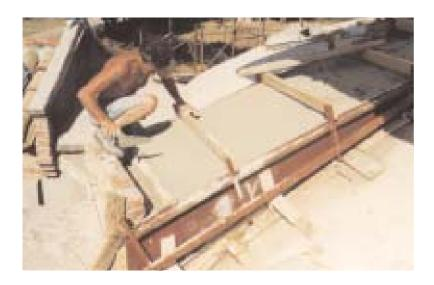
collegati ai cavallotti lasciati sporgere dagli archi, e da una sovrastante rete elettrosaldata con maglia 50x50 Ø 3 mm. Per garantire lo spessore del getto all'attacco della calotta è stato fissato con tasselli espansivi Ø 6 un pro-
